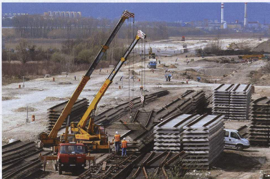
Hlavní aktéri na dostavbe Zriaďovacej stanice v Žiline-Tepličke sú odbornej verejnosti dobre známi. Menej sa už vie, že medzi dodávateľmi nechýba ani Trnavská stavebná spoločnosť, ktorá má na starosti realizáciu železničného zvršku. Kolajové polia sa montujú na montážnej základni z kolajnic tvaru S49 a podvalov SB 8P. Následne sa pokladajú pokladačom kolajových polí PKP 25/20. Investorm stavby sú ŽSR. Snímka ŽSR
