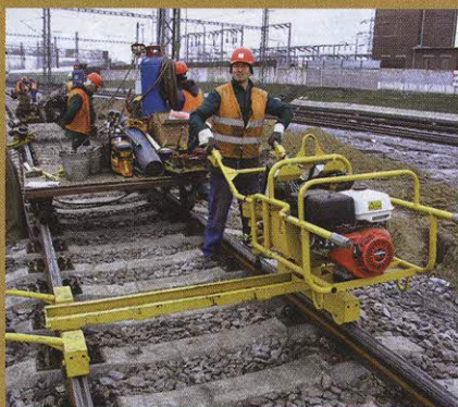
Zriaďovanie bezstykovej koľaje pomocou dvojvretenej uťahovačky typu Geismar T 2002 s digitálnym výstupom uťahovacieho momentu.
